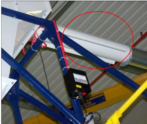
6000 离子管安装在分离器的上游
