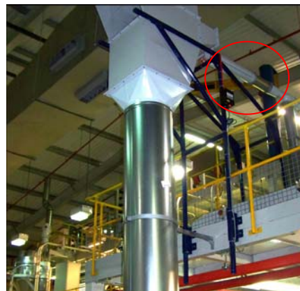
6000 离子管安装在分离器的上游
